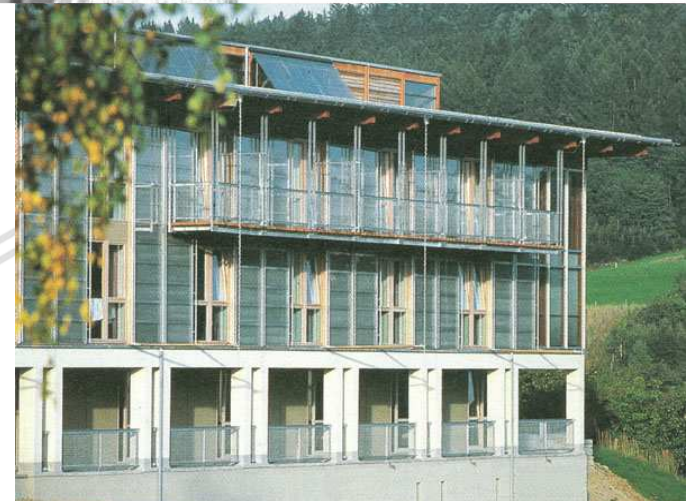
Muros Trombe en la fachada sur del Albergue Juvenil en Windberf. Arquitecto Tomas Herzog
